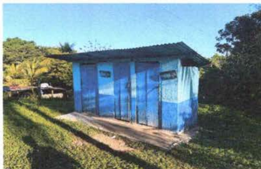
Foto 4: SE OBSERVAN LAS PUERTAS YA DETERIORADAS POR EL TIEMPO QUE LLEVAN DE USO
