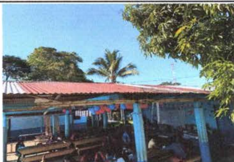
SE OBSERVA LA LAMINA EN MAL ESTADO DETERIORADA
