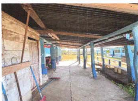
SE OBSERVAN LAS COLUMNAS DE MADERA LAS CUALES YA ESTAN DETERIORADAS
