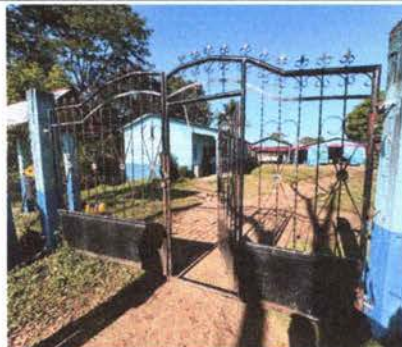
Foto 2: SE OBSERVA DETERIORO DE LA PINTURA DEL PORTONO PRINCIPAL Y LA LAMINA DE ABAJO QUE SE ENCUENTRA OXIDADO
